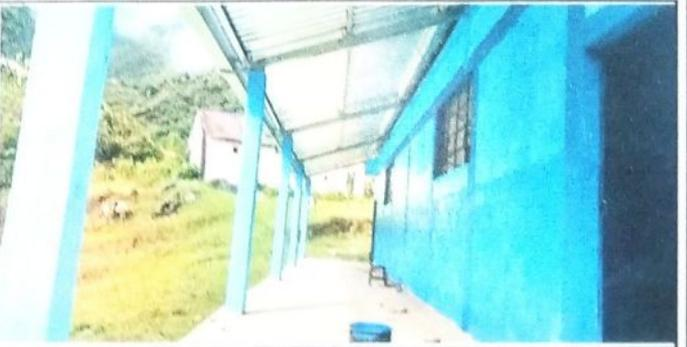
Foto 6: Observandose los diferentes procesos realizados del establecimiento, cambio de laminas troqueladas, habllación y instalacón de puertas de metal y canales troqueladas
